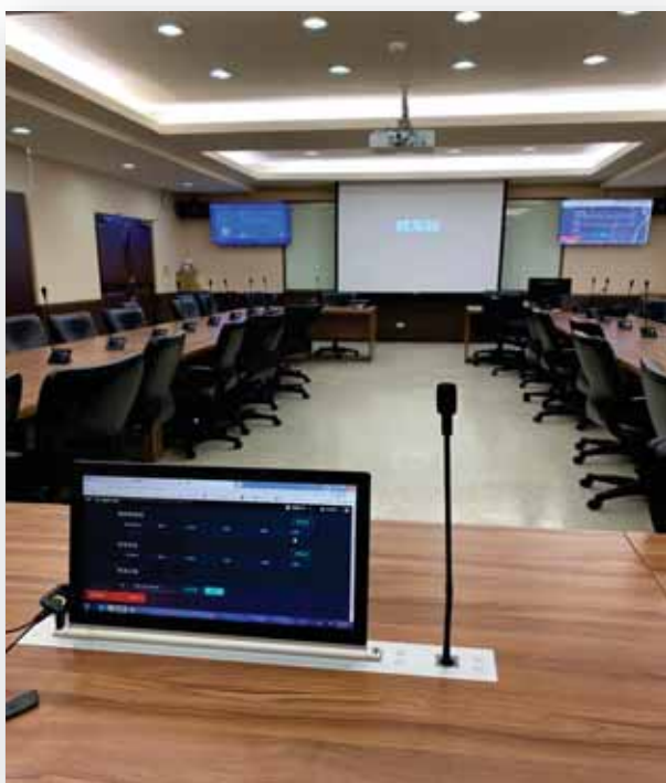
▲ 樹德樓317會議室遠距設備第一期改善工程驗收
